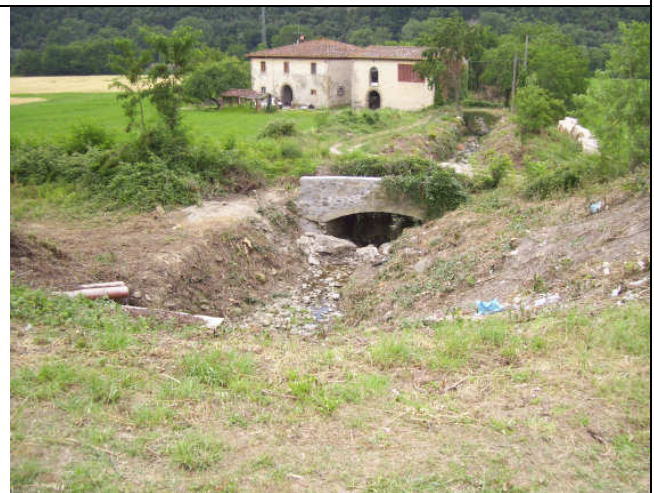
Fosso dei Casini (2) dopo l'intervento, tratto n. 4, da monte verso valle
