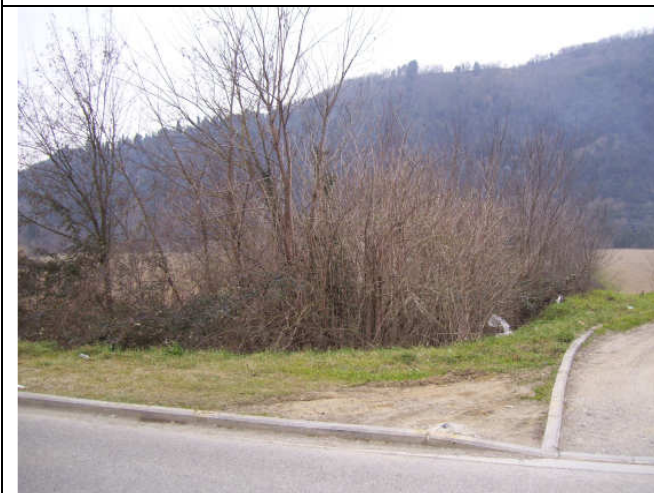
Fosso dei Casini (2) prima dell'intervento, tratto n. 4, da monte verso valle
